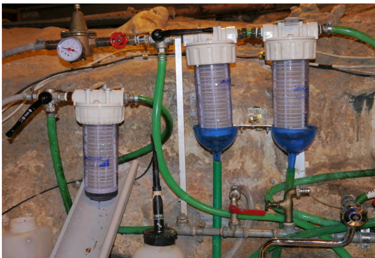
Impianto di filtrazione e distribuzione delle acque
