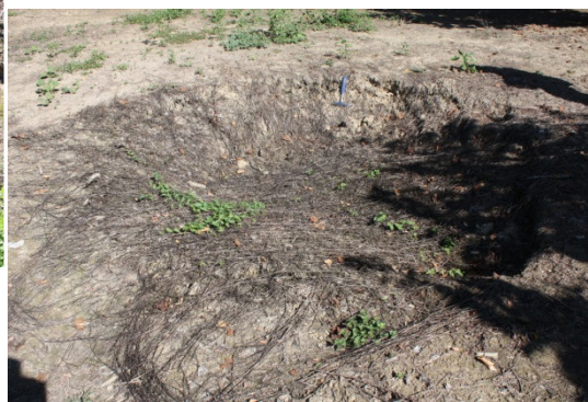
Foto 1 – Ripresa dei fenomeni di cedimento su cavità rinterrata dalle attività antropiche (sh21 e sh06)
