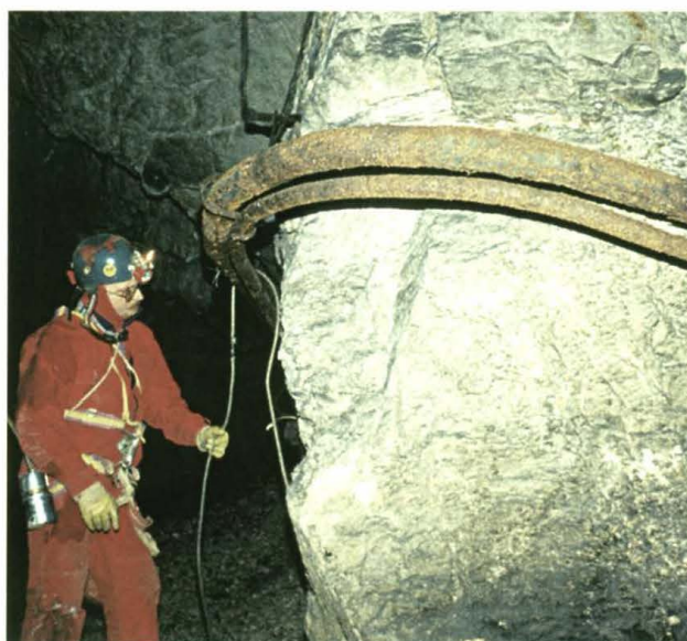
TOUROUSELA: residui di condotte aria ed acqua nella galleria principale
